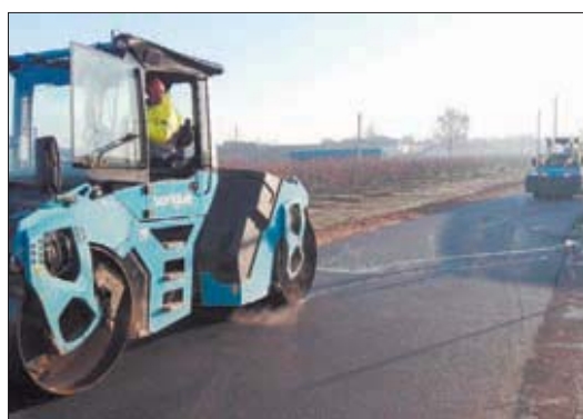
FOTO: Ajuntament Torrefarrera / Dos màquines treballant a les obres
