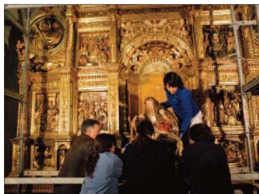
Un moment dels treballs de remuntatge de l'obra.
