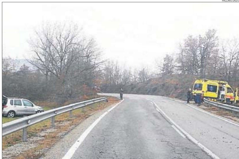
Imatge d'un dels accidents recents en aquest punt negre de la carretera C-1412b a Isona.
