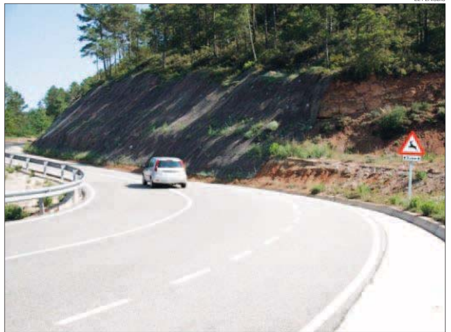
►► Un tram de carretera senyalitzat com a zona perillosa a causa d'animals en llibertat.
