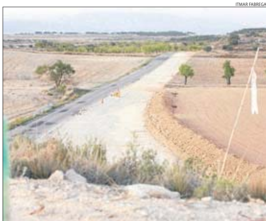
Les obres a la carretera d'Aspa a Artesa de Lleida, aturades.
