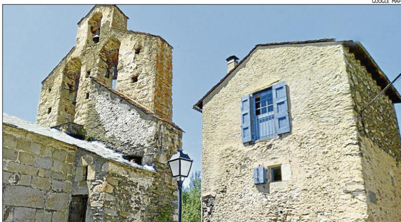
L'església de Sant Esteve de Guils amb una de les cases que té a tocar de la façana i que la tapen
