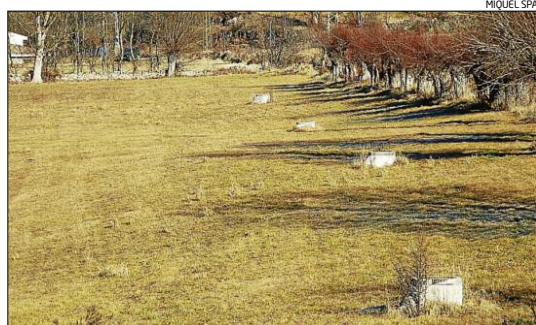
Els pous del col·lector de Pi, que travessa els camps fins a Bellver
