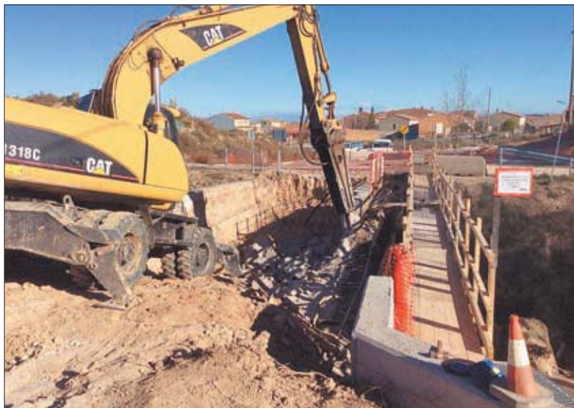
FOTO: Diputació de Lleida / Una màquina fent els treballs de demolició d'un dels ponts sobre el Canal d'Urgell
