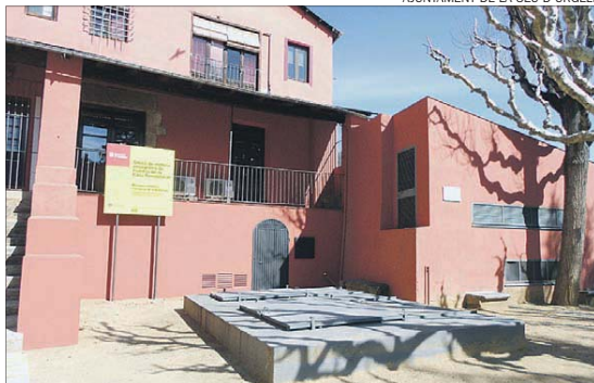
Les obres han inclòs la substitució de la fusteria exterior.
