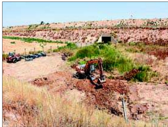
FOTO: Núria García / Diverses màquines treballant a la zona de l'obra
