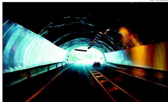
► Un dels túnels del terme de Coll de Nargó on es va produir l'accident.
