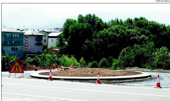
► Les obres de la rotonda d'entrada a la Seu d'Urgell.
