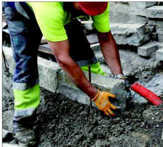
Un operari treballant en una obra.
