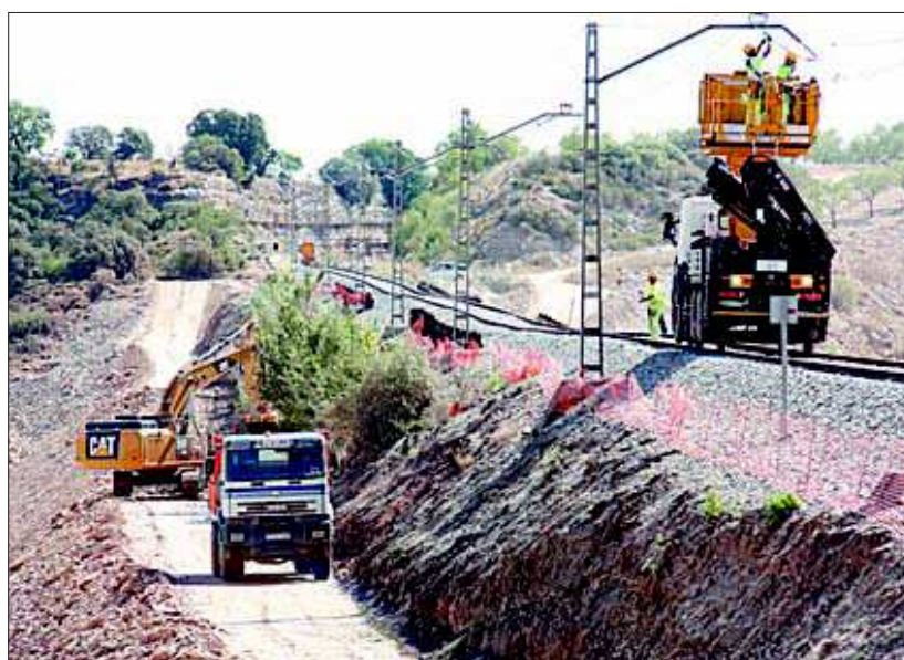
FOTO: O. Bosch (ACN) / Operaris retirant la catenària al punt del terraplè de la Granyanella a la R-12
