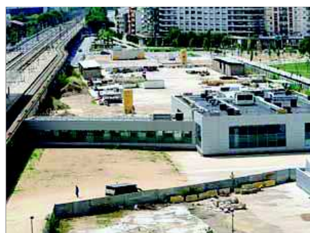
Vista de la zona de la llosa al parc Central, amb el 'finger' que s'ha d'enderroc ■ MANEL LLADÓ
