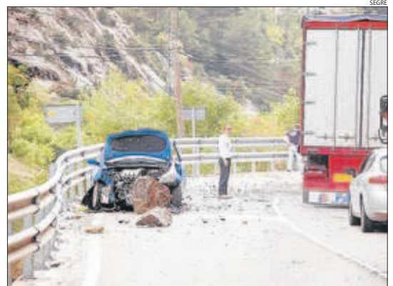
El túnel de Tres Ponts ha d'evitar els despeniments a la C-14.
