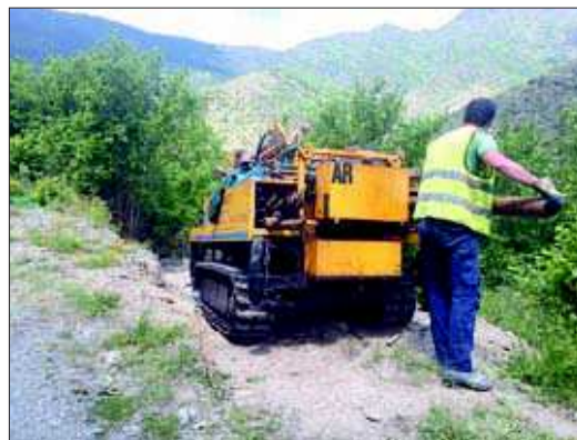
FOTO: / Una màquina treballant dijous a la zona
