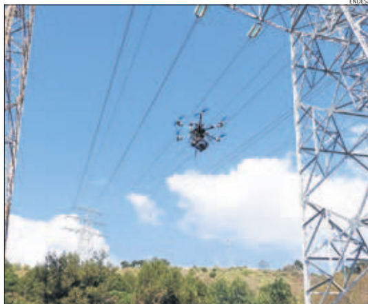
Un dron utilitzat en la revisió de línies elèctriques.
