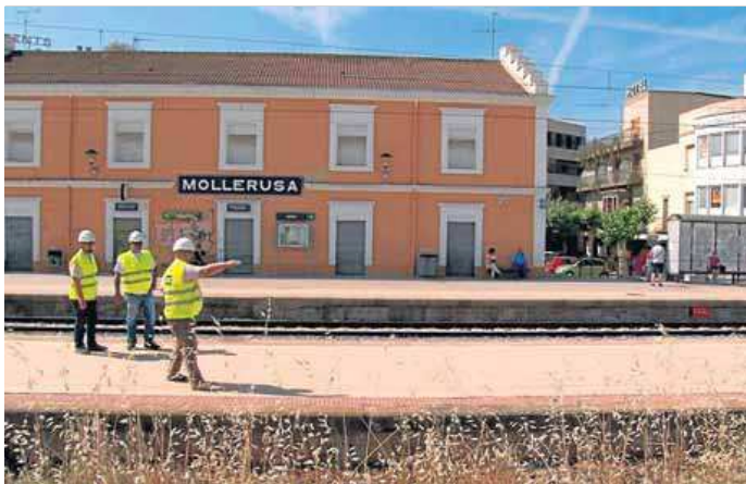
Operaris inspeccionant la zona on es construirà el pas subterrani ■ MOLLERUSSA TELEVISIÓ
