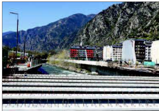
Les obres de construcció de l'estació de busos.
