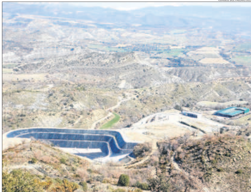
L'abocador intercomarcal de Figols, ampliat fa un any, podrà rebre escombraries durant dos dècades.
