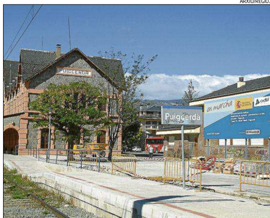
El solar on l'Ajuntament vol construir la demandada estació de bus
