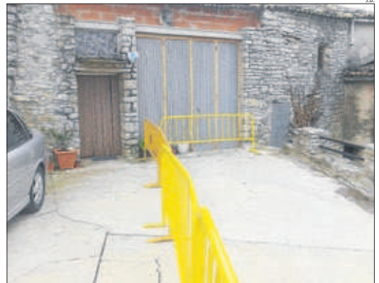
El garatge de la família amb tanques per les esquerdes a terra.
