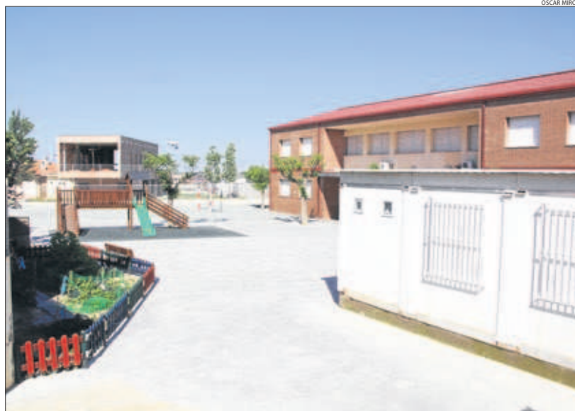
Benavent de Segrià té un mòdul que utilitza com a menjador; al fons l'estructura de la guarderia.
