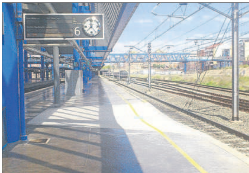
Nova rampa a l'andana de Lleida del tren de la Pobla per a l'accés amb cadira de rodes.
