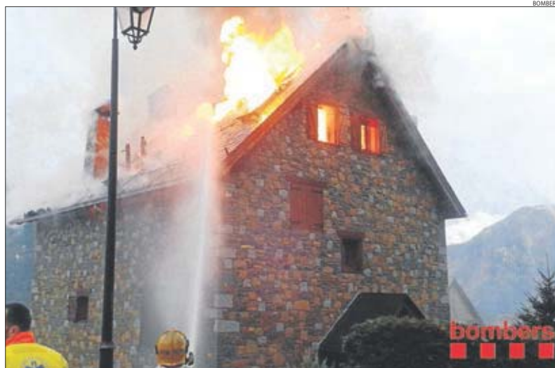
El foc es va originar a l'àtic i va cremar per complet la coberta de fusta de l'edifici.
