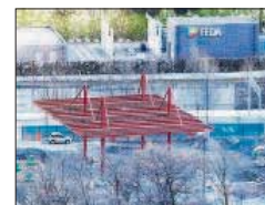
Les obres de la benzinera.
