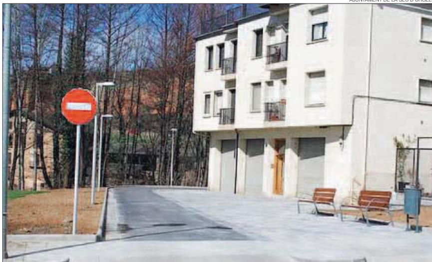
► Obres de reurbanització realitzades a la zona Mallol de la Seu d'Urgell.
