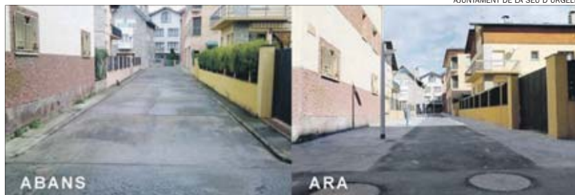
Aspecte d'un dels carrers afectats per les obres i com queda a partir d'ara.
