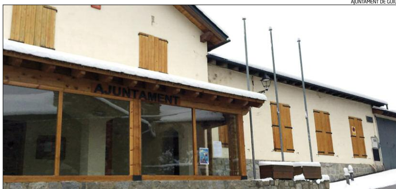
L'edifici de l'Ajuntament de Guils, amb els locals que es reobriran
