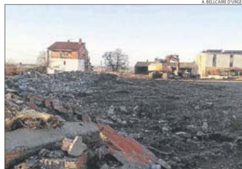
Obres d'enderroc d'una granja abandonada i en ruïna.
