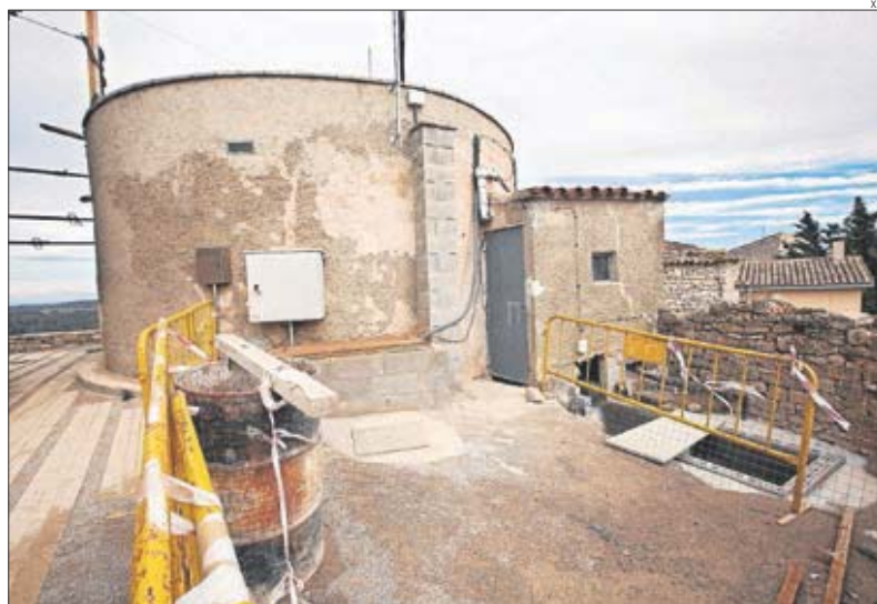
Imatge dels treballs que es porten a terme per posar fi a les filtracions a l'Ametlla.
