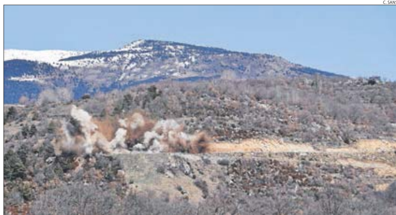
Les voladures van requerir 1.200 quilos d'explosius per desplaçar 2.500 metres cúbics de roques.
