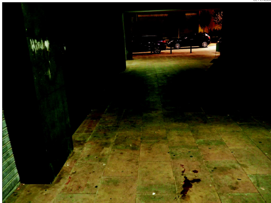
► El túnel interior dels blocs de pisos de la plaça Camp del Codina, una de les zones afectades per l'incivisme.
