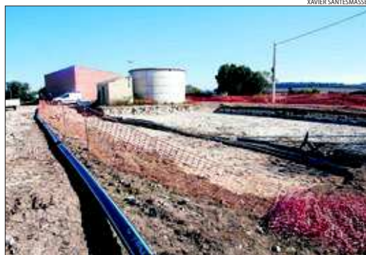
Les obres de construcció del dipòsit d'aigua.
