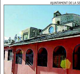
La coberta de la banda de llevant que se substituirà
