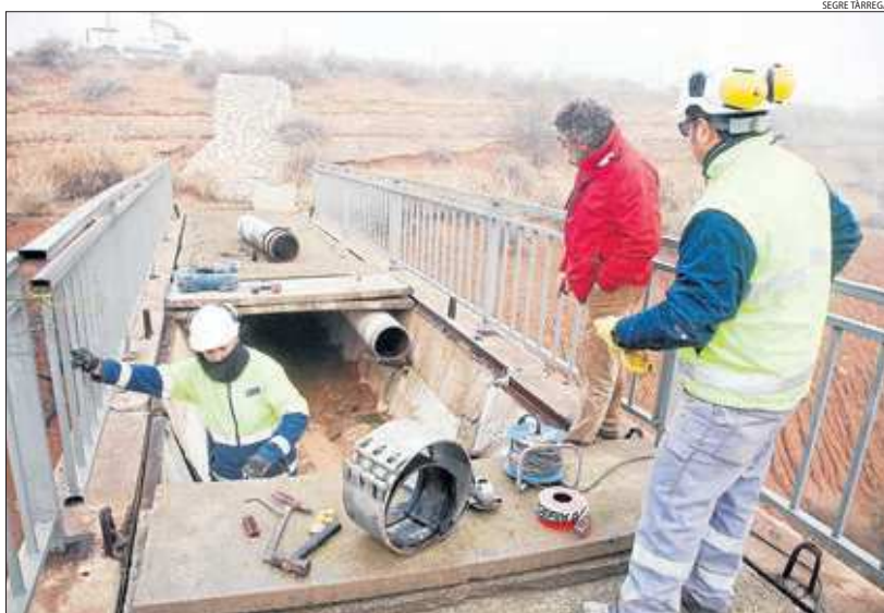
Operaris de l'empresa concessionària treballaven al matí per reparar la canonada trencada.
