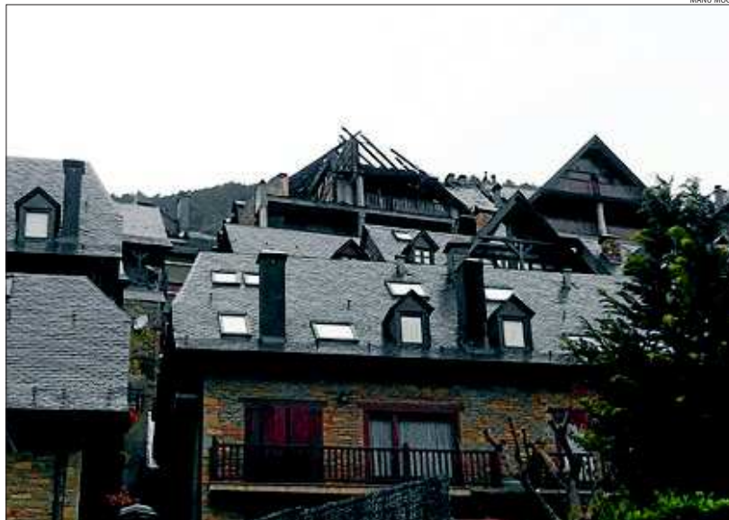
Vista aèria del bloc d'habitatges afectat per l'incendi a la localitat de Gausac.
