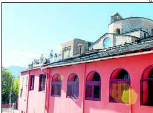
Els operaris van començar ahir a desmuntar la teulada.
