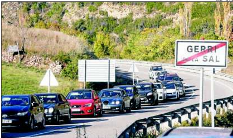
Cua de vehicles a l'entrada de Gerri, on hi ha pas alternatiu per les obres d'ampliació.
