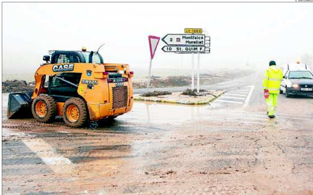
Els treballs a la carretera entre les Oluges i Sant Guim de Freixenet.
