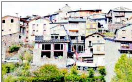
FOTO: ACN / Una de les cases s'està construint a Taús
