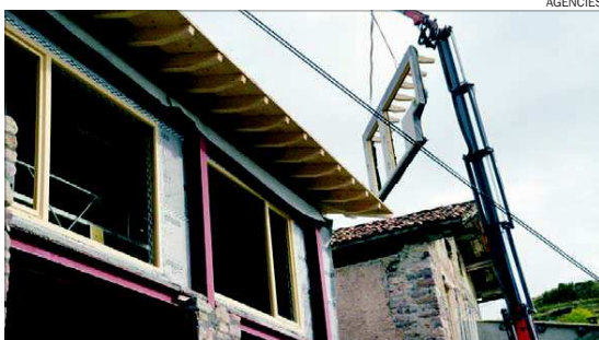
Els quatre apartaments s'estan construint aquesta setmana.
