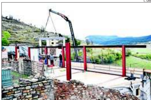
Imatge de les obres d'un dels allotjaments rurals de Taús.
