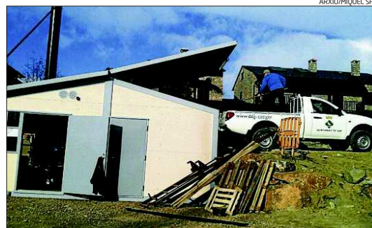
Operaris de Ger omplen la sitja de biomassa de la caldera de l'escola
