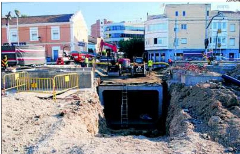
Les obres per instal·lar una caixa prefabricada, element principal del pas soterrat.
