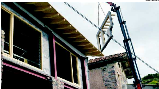
Els quatre apartaments s'estan construint aquesta setmana.
