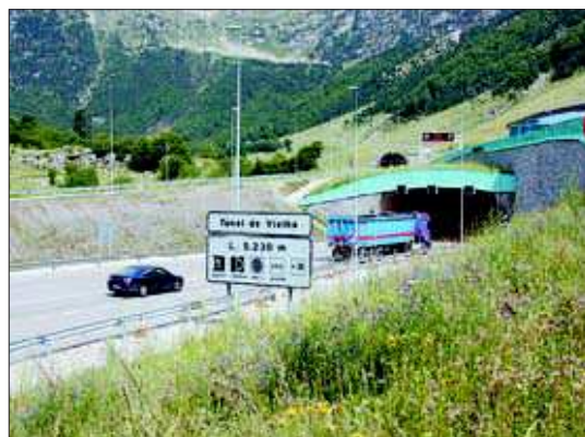
FOTO: / Imatge d'una de les boques del Túnel de Vielha
