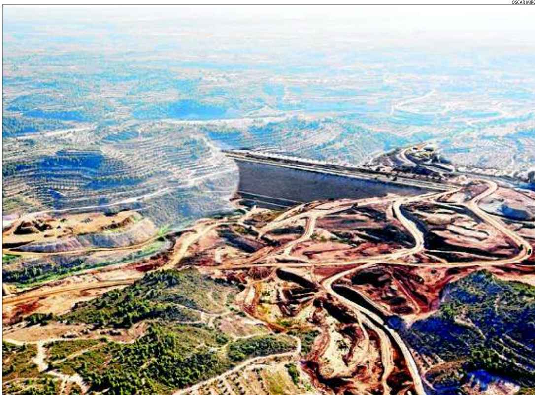
La presa de l'Albagés, amb un 90% de l'altura total ja aixecada, contindrà les aigües del riu Set i del Segarra-Garrigues.
