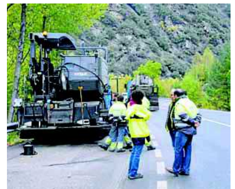
Operaris a peu de carretera on han començat les obres per reforçar el paviment ■ ACN
