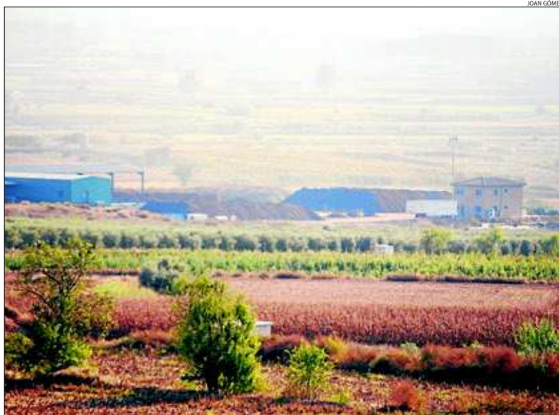
Vista de la planta de compostatge d'Arpla de Torregrossa.
