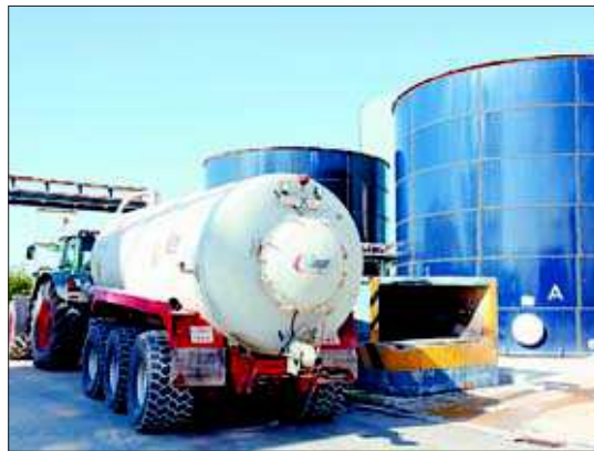
FOTO: O.Bosch (ACN) / Imatge de la planta de purins de Miralcamp, ahir
