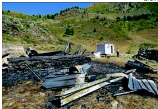
Aquest és l'estat en què va quedar el refugi anterior.
