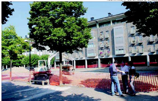
Els responsables municipals durant una visita a les obres en marxa.
