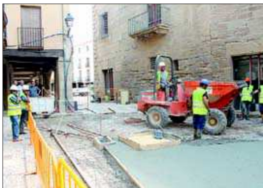
FOTO: / Ara s'està fent la pavimentació dels carrers urbans
