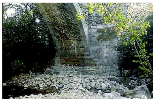
El pont de Sant Martí i, a baix, la base que ha estat reforçada
