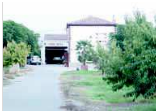
FOTO: Lúdia Sabaté / Façana de la casa on estava treballant l'home
