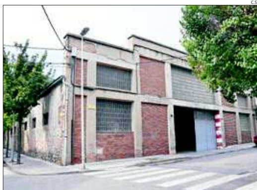
L'edifici que es demolirà per fer el nou CAP.
