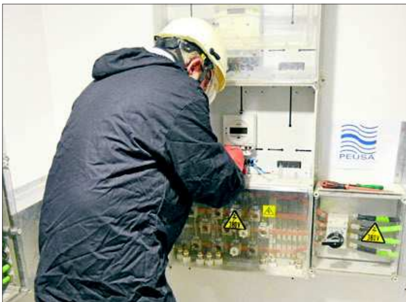
Un operari de Peusa, l'elèctrica de l'Alt Urgell, instal·lant un comptador intel·ligent.
